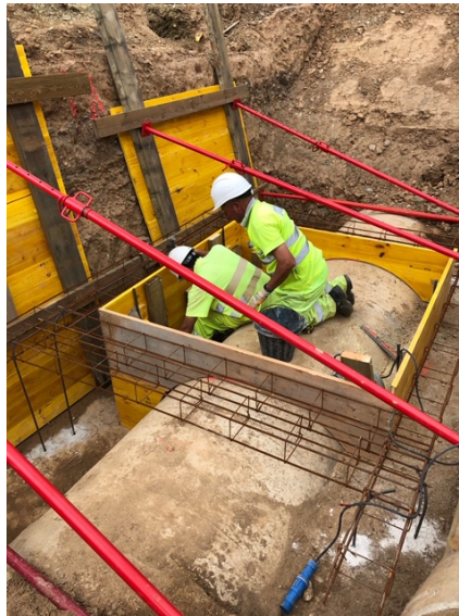
Ejecución de pozo
